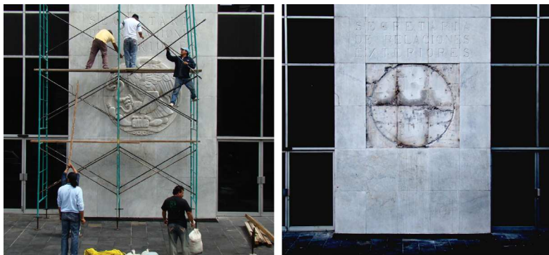
Figura 3. Imágenes de la acción Desmantelamiento y reinstalación del escudo nacional
